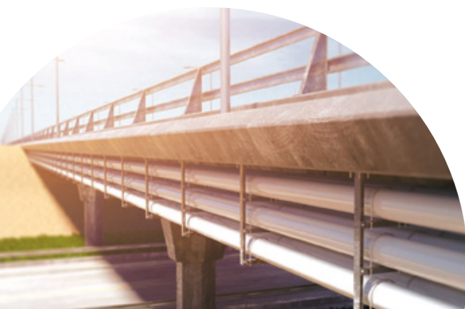
Рис. 14. Прокладка кабельной линии вдоль моста с применением трубы ПротекторФлекс® НГ
